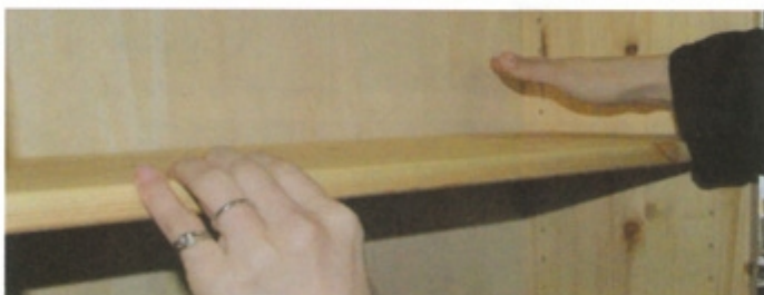
⑪ 棚板の両端に埋め込まれた特殊な金具の位置に棚板用受けネジがしっかり収まるように、上から軽く叩いて押し込みます。
